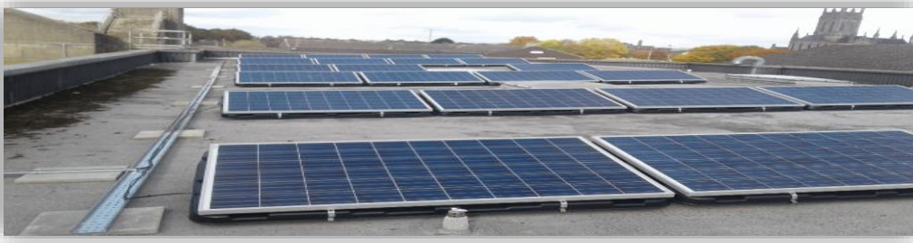
Painéil fhótavoltacha 6kWp i Stáisiún Dóiteán Chill Chainnigh
